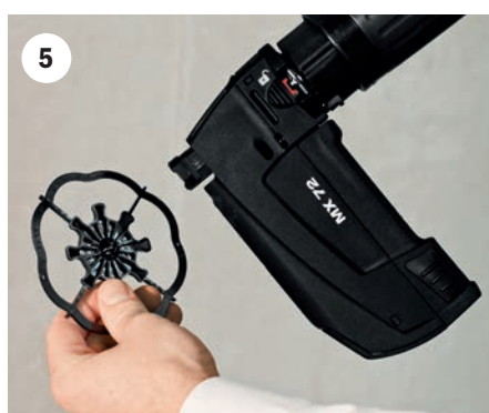
5 Nasadte lepicí kotvu Baumit StarTrack X1. Díky speciální geometrii drží sama.
