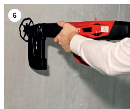
6 Přiložte ke zdi – přitlačte vsazovací přístroj a zmáčkněte spoušť. Lepicí kotva Baumit StarTrack X1 je osazena!
